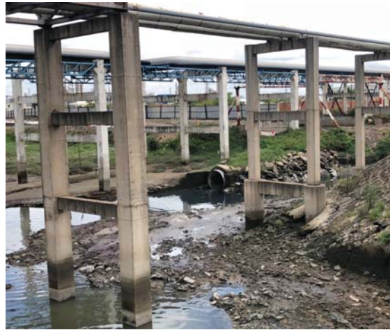
图 2-14 南柳河入海口段黑臭严重
