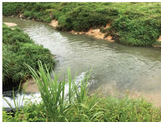
图 2-6 麻章污水厂出水口
